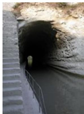
Le tunnel du Malpas a été percé sur une longueur de 170 mètres, dans des grès sableux, avec un risque permanent d'effondrement, dans l'hiver 1679-1680.
