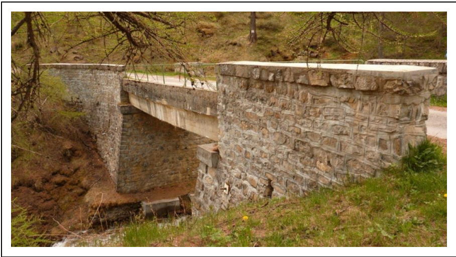
photo ASCEE 05 – juin 2019 – le pont et son tablier d'origine
