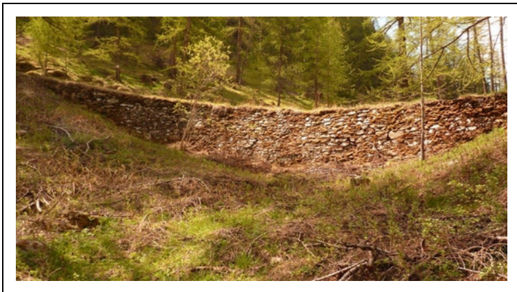
photo ASCEE 05 – juin 2019 – un mur au-delà du pont
