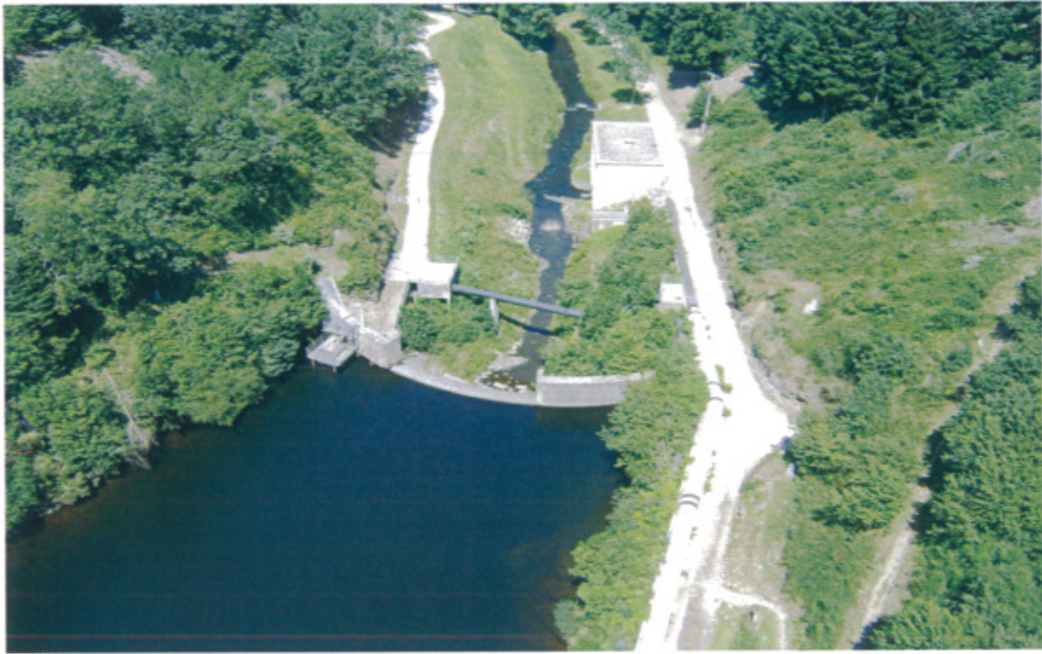
VUE DE SUR LA DIGUE VERS SA BASE
